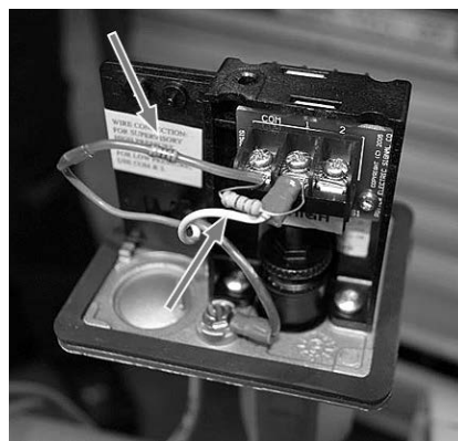
Նկար 7 Ճնշման ռելեի հենամարմնում դիմադրությունների (ռեզիստորների) տեղադրման օրինակ
