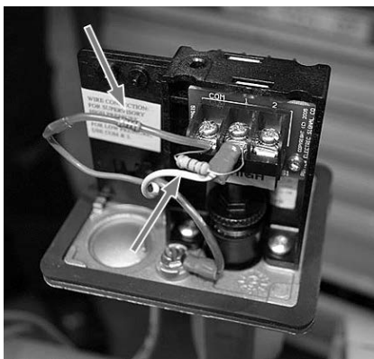
7-сүр. Басым релесинин корпусунда каршылыктарды (резисторлорду) орнотуу мисалы
