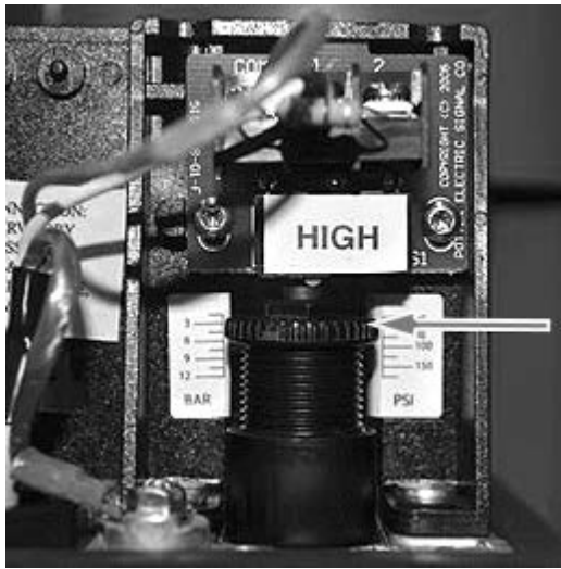
9-сүр. Potter басым релесин тууралоо
