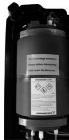
Նկար 40 Ռեակտոր՝ OCD-162-10 ներքին բաժնավորիչ ռեգերվուարով
