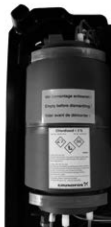
40-сүр. Ички өлчөмдөөчү резервуары менен OCD-162-10 реактору
