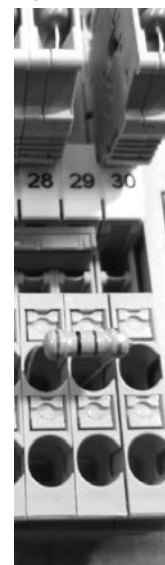
Նկար 4 PTC տվիչի միացման սեղմակներում դիմադրության (ռեզիստորի) տեղադրման օրինակ:
