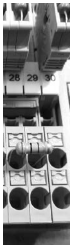
Рис. 7 Пример установки сопротивления (резистора)
