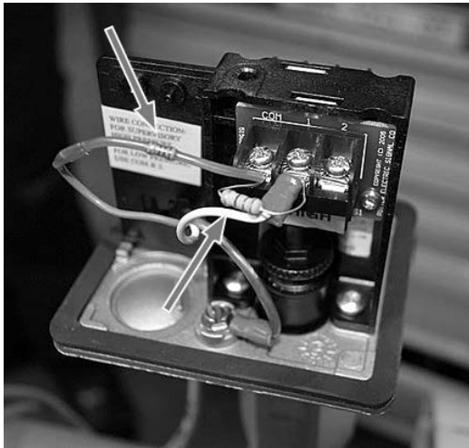
Рис. 6 Пример установки сопротивлений (резисторов) в корпусе реле давления
