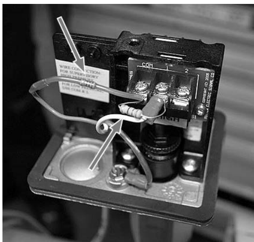
6-сур. Қысым релесі корпусына кедергілерді (резисторлар) орнату мысалы
