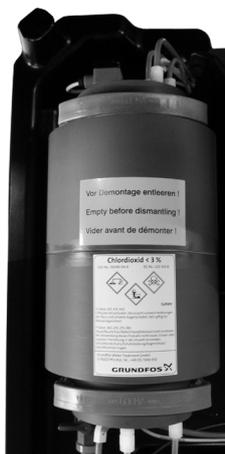
**Рис. 39** Реактор с внутренним дозирочным резервуаром OCD-162-10
