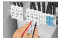
Замеренные значения напряжения должны быть 450 ± 25 В, когда CUE настроен на частоту 50 Гц/1500 об/мин и подключен к источнику питания 400 В.
